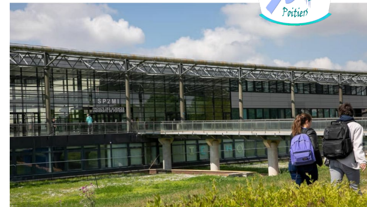
Le datacenter sera implanté sur le campus de l'université sur la technopole du Futuroscope à Chasseneuil-du-Poitou. © Photo NR-CP, Mathieu Herduin
